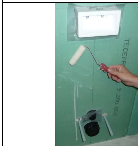
3. Påfør primer på frontplaten
