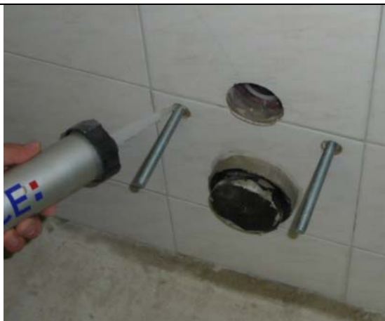
8a. Fyll de to hullene rundt gjengeboltene fullstendig med elastisk tettemasse
