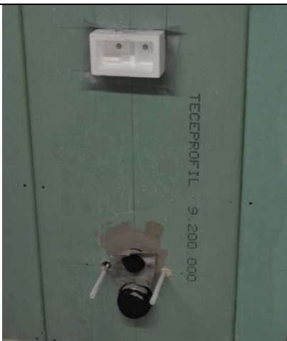
4. Påfør smøremembran på de aktuelle stedene.
