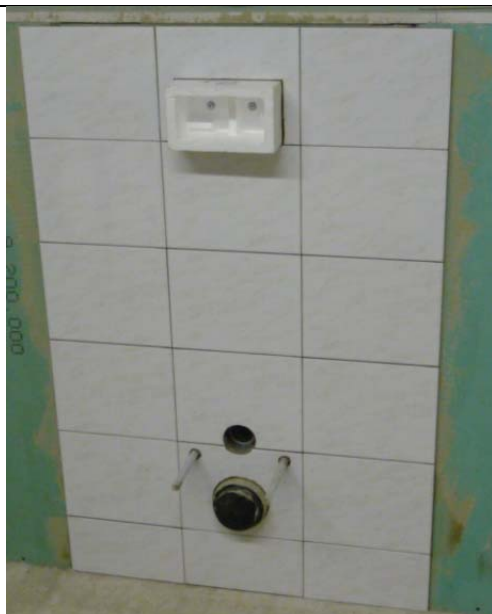
6a. Første trinn av flismontasjen
