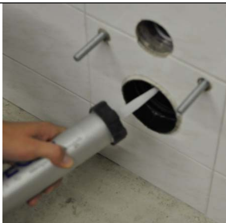
8b. Fyll også overgangen mellom avløpsbendet og resten av beskyttelsestersen med tettemassen.
