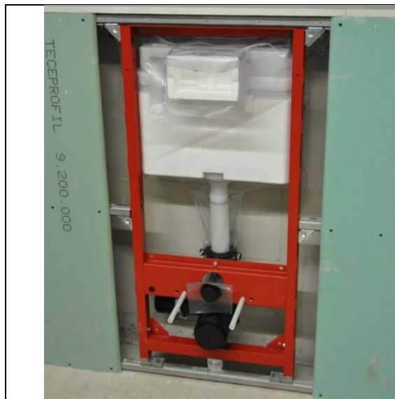
1. Installer WC-modulen i veggen
