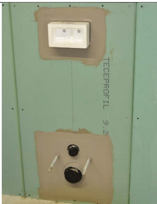
5c. Påfør omgående lag 2 etter at flensen er strøket på plass og glatt ut.
