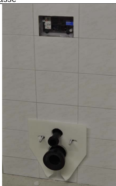
9. Etter at tettemassen har herdet, kan montasjen av porselent forberedes ved å sette støydempingen på plass.
