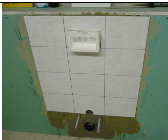
6b. Andre trinn av flismontasjen
