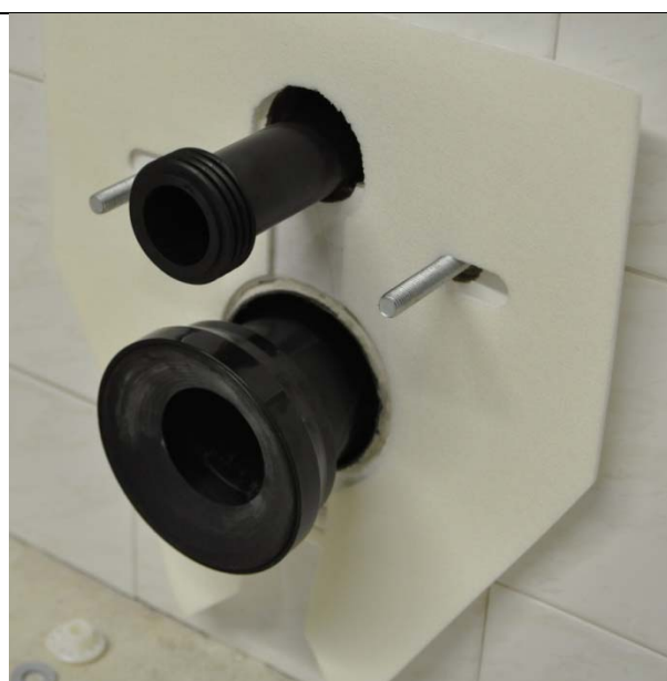
9. Etter at tettemassen har herdet, kan montasjen av porselent forberedes ved å sette støydempingen på plass.
