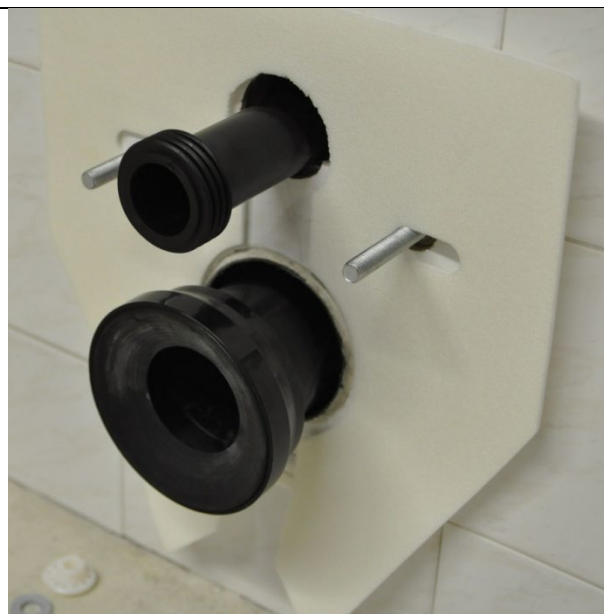
9. Etter at tettemassen har herdet, kan montasjen av porselent forberedes ved å sette skumplaten på plass. NB! Skumplaten bør monteres, da den sørger for drensåpning i tillegg til støydemping.
