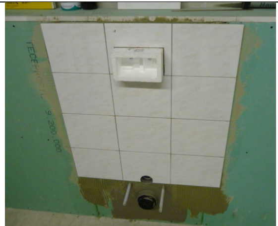
6b. Andre trinn av flismontasjen
