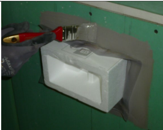
5a. Påfør det første laget smøremembran i området ved betjeningsplaten
