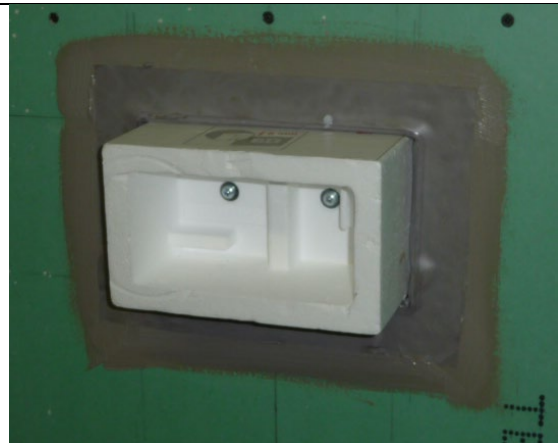
5b. Trykk flensen på plass i den fuktige smøremembranen og jevn ut, spesielt godt langs den innerste kanten.
