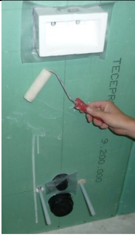
3. Påfør primer på frontplaten
