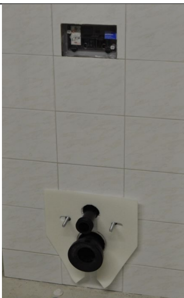
9. Etter at tettemassen har herdet, kan montasjen av porselent forberedes ved å sette skumplaten på plass. NB! Skumplaten bør monteres, da den sørger for drensåpning i tillegg til støydemping.
