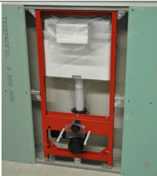
1. Installer WC-modulen i veggen.
